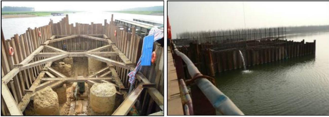
图 5.3.1-1 安徽怀洪新河桥梁桩基施工设置钢围堰周围保持水体清澈
